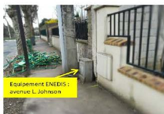
82 pavillons étaient menacés de coupure, non pas en fonction du positionnement de leur boîtier de raccordement, mais à cause de la hauteur insuffisante des boîtiers de distribution appartenant à ENEDIS, comme le montrent les deux photos.
